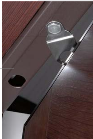
Μεταλλική πρόκασα & κυρίως κάσα σε διάφορα χρώματα RAL Metal subframe and main frame in various RAL colours
